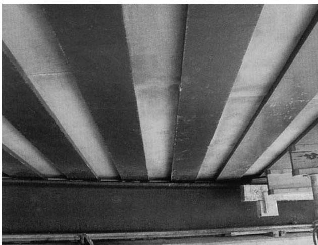
Eterboard als Verlorene Schalung auf Stahlträgern im Brückenbau.
